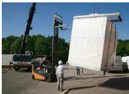
Aanvoer Prefab badkamer/toilet (Bron: Faay)
