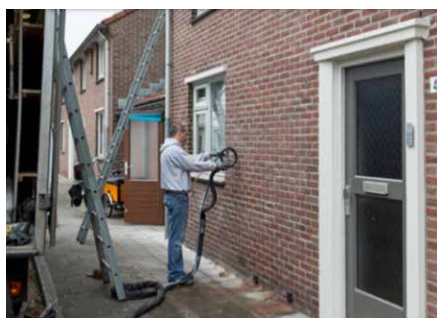
aanbrengen gevelisolatie (Bron: Caspar de Haan)
